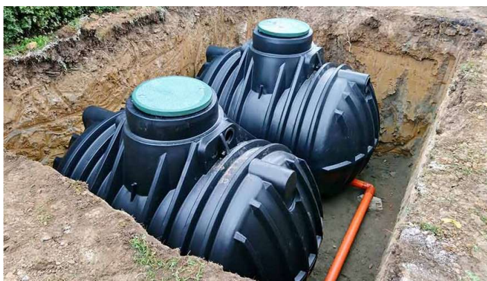
▲ Um bei der Bewässerung des Gartens Wasserkosten zu sparen, bietet es sich an, Regenwasser in unterirdischen Tanks zu speichern. Foto: JHphoto/bigstockphoto
