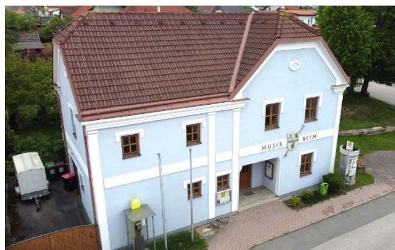
▲ Auf dem Dach des Musikheims wird im Sommer eine Photovoltaikanlage mittels Bürgerbeteiligung errichtet. Module können bei der Gemeinde erworben werden.
